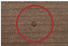
Dépôt naturel de fibres avant traitement
