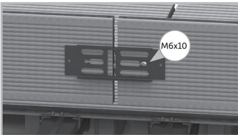
Bei Kopfseitigen Fugen im Schiffsverband Distanz Fix auf doppelter Unterkonstruktion mittig zwischen den Terrassendielen auflegen. An außenliegenden Terrassendielen den Distanz Fix von unten verschrauben. Dazu beide Dielen aufstellen, Distanz Fix positionieren, verschrauben und wieder hinlegen.
